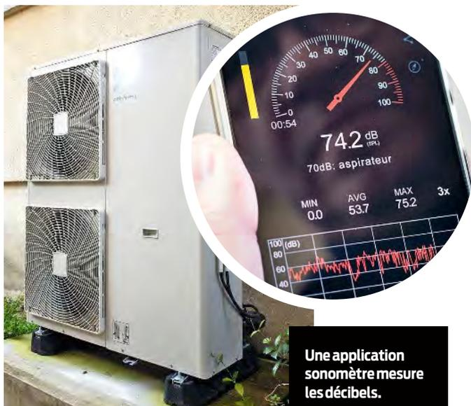
Une application sonomètre mesure les décibels.
